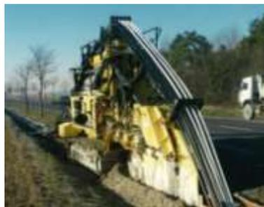
De conception compacte, la gamme SERIE 1 est idéale pour réaliser la jonction de fourreaux TELECOM : dimensions compatibles avec les peignes de la trancheuse.
